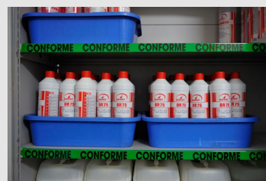
Armoire de stockage avec bacs de rétention pour les produits de nettoyage d'une entreprise
